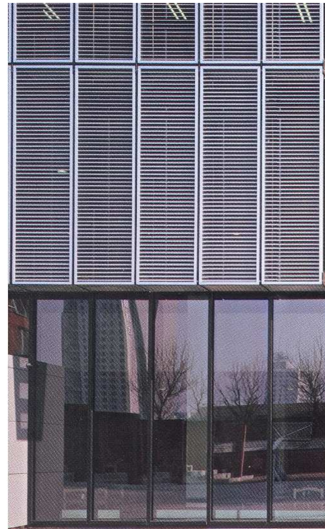
VERSCHATTUNG DES AUFZUGTURMS AN DER SÜDSEITE (INNENHOF)
